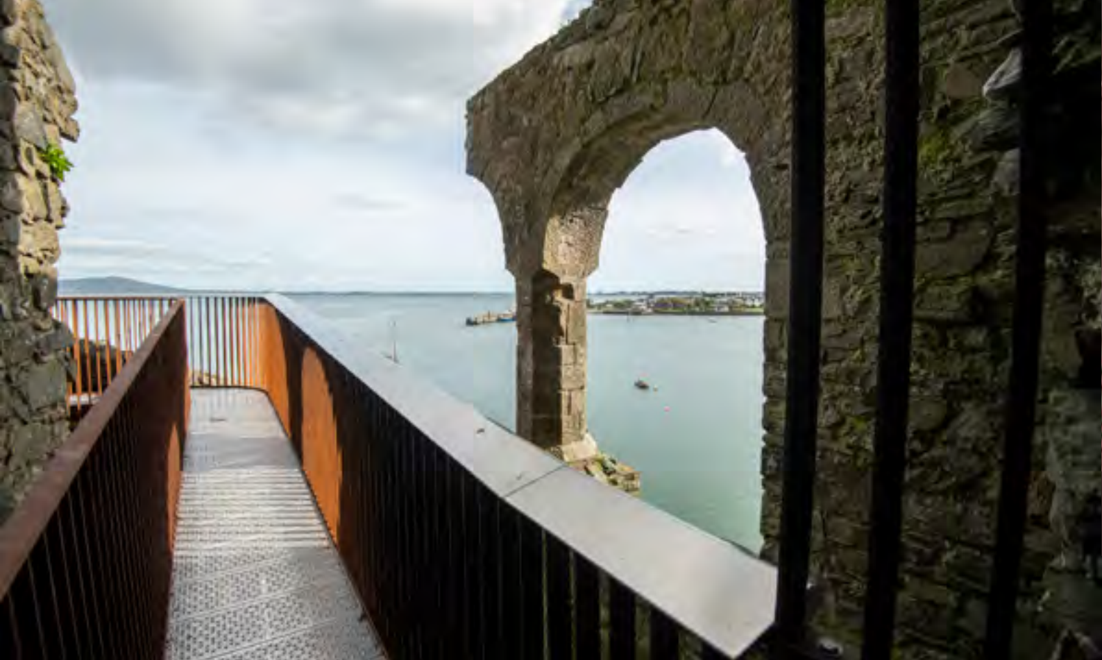
Caisleán Chairlinn, Contae Lú, idirghabhálacha le Howley Hayes Architects / Oifig na nOibreacha Poiblí. Buaiteoir ghradam RIAI, 2021. Grianghraf le John Lalor, RTRAO
