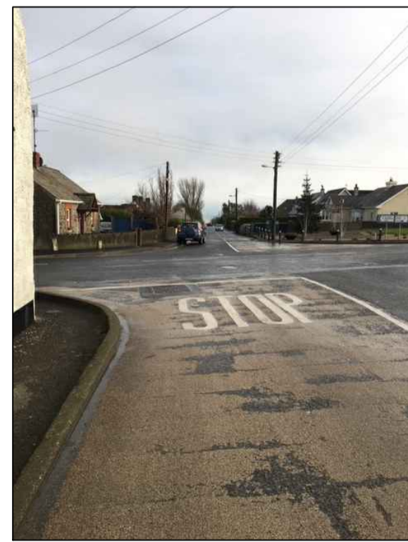
SITE PHOTOGRAPH 3 (SCALE: N.T.S.)
