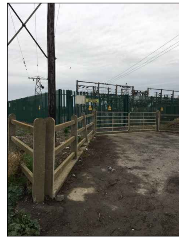
SITE PHOTOGRAPH 1 (SCALE: N.T.S.)
